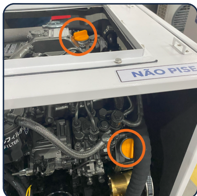
Abastecimento do óleo lubrificante
