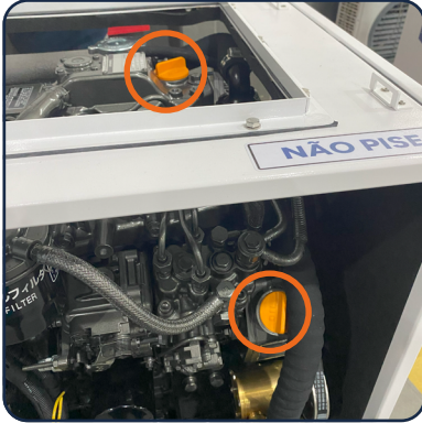
Abastecimento do óleo lubrificante
