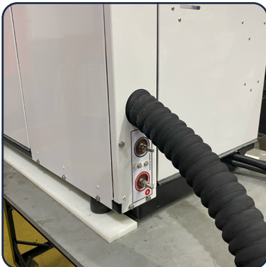
Ligação dos cabos da bateria e mangote de saída de escape
