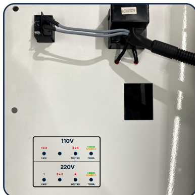
Lado interno do painel
