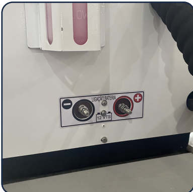
Ligação dos cabos da bateria
