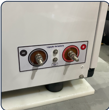
Ligação dos cabos da bateria
