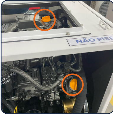
Abastecimento do óleo lubrificante
